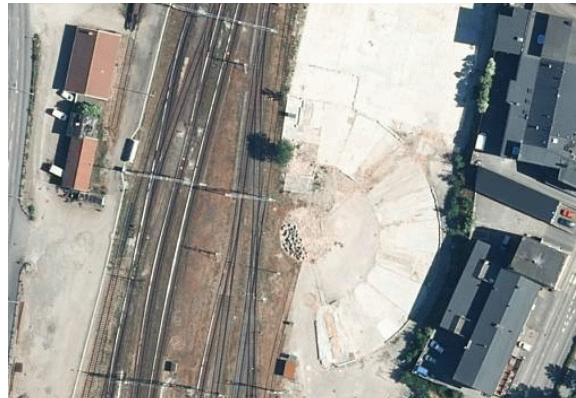
Fundamenter fra rundremisen i Varberg kan ses; eksisterede i 2012 . Kilde: https://kartor.eniro.se/
